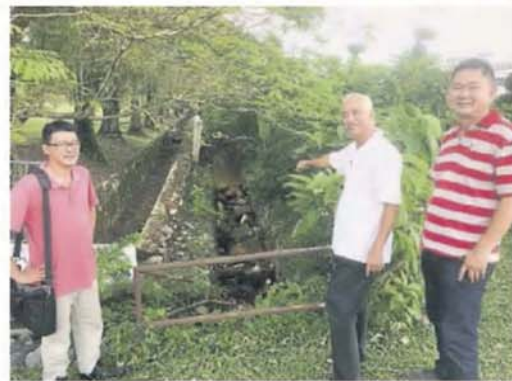
人维修。翠岭镇国中围墙倒人沟渠已多年，都没
